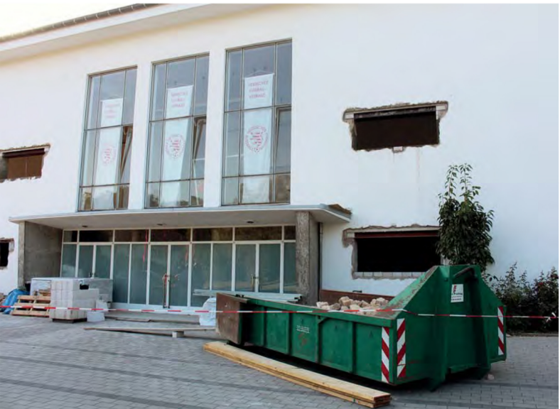
Im früheren Eingangsbereich der alten Sporthalle entsteht derzeit ein moderner Sauna- und Wellnessbereich. Foto: Frank Schneider
